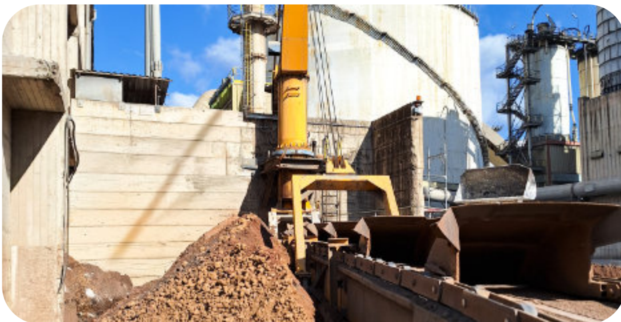
Alimentazione tramoggia della pozzolana
